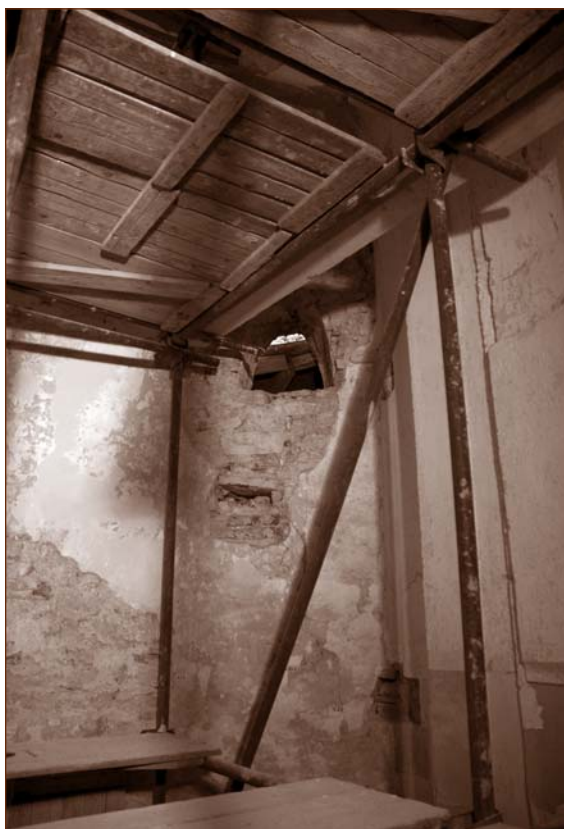
Umiestnenie najstaršieho okna v interiéri. Obr. 15
