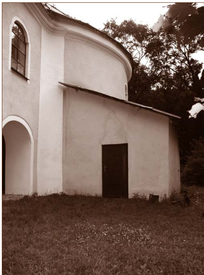
Pristavba pustomne k južnej stene rotundy z konca 16. storočia. Obr. 8
