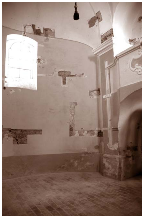
Sondážny výskum na južnej stene interiéru rotundy. Obr. 10
