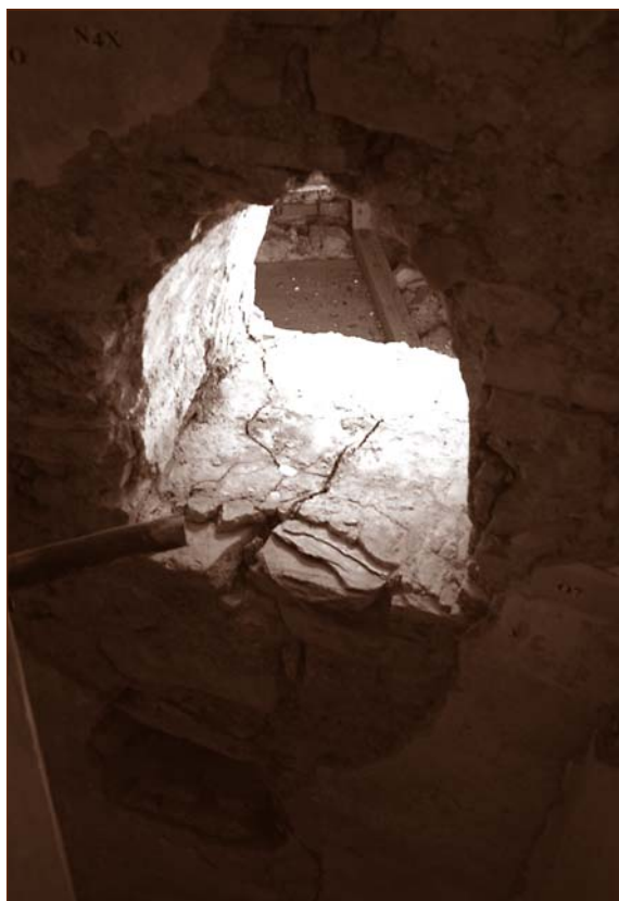
Detail najstaršieho okna zo strany interiéru. Obr. 14
