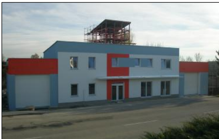
Budova Obecnej hasičskej zbrojnice pred dokončením
